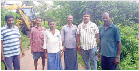
రోడ్డుకు ఇరువైపులా ఉన్నటువంటి చెట్లను తొలగించేందుకు పనిచేస్తున్న అధికారులు
